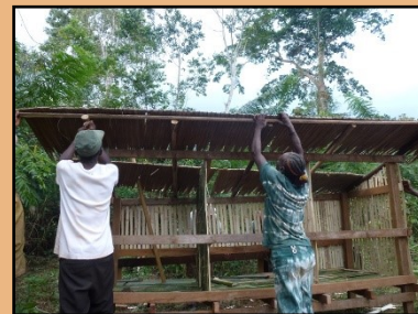
Construction du poulailler
